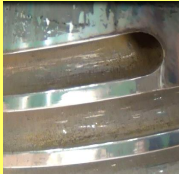
汚れた穴と溝
